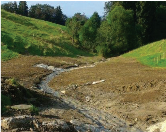
Steinschlagschutz Charmey; Realisierung 20??
