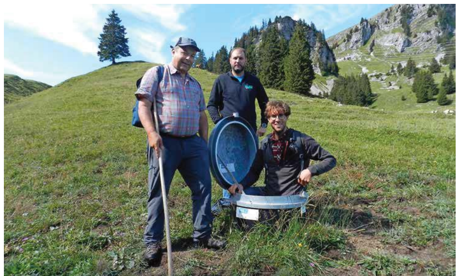
Andreas Freiburghaus, Präsident der Alpgenossenschaft, Sanitärinstallateur Bruno Raemy und Ingenieur Andreas Wicky (von links nach rechts) beim neuen Pumpschacht zwischen den beiden Alpen.
